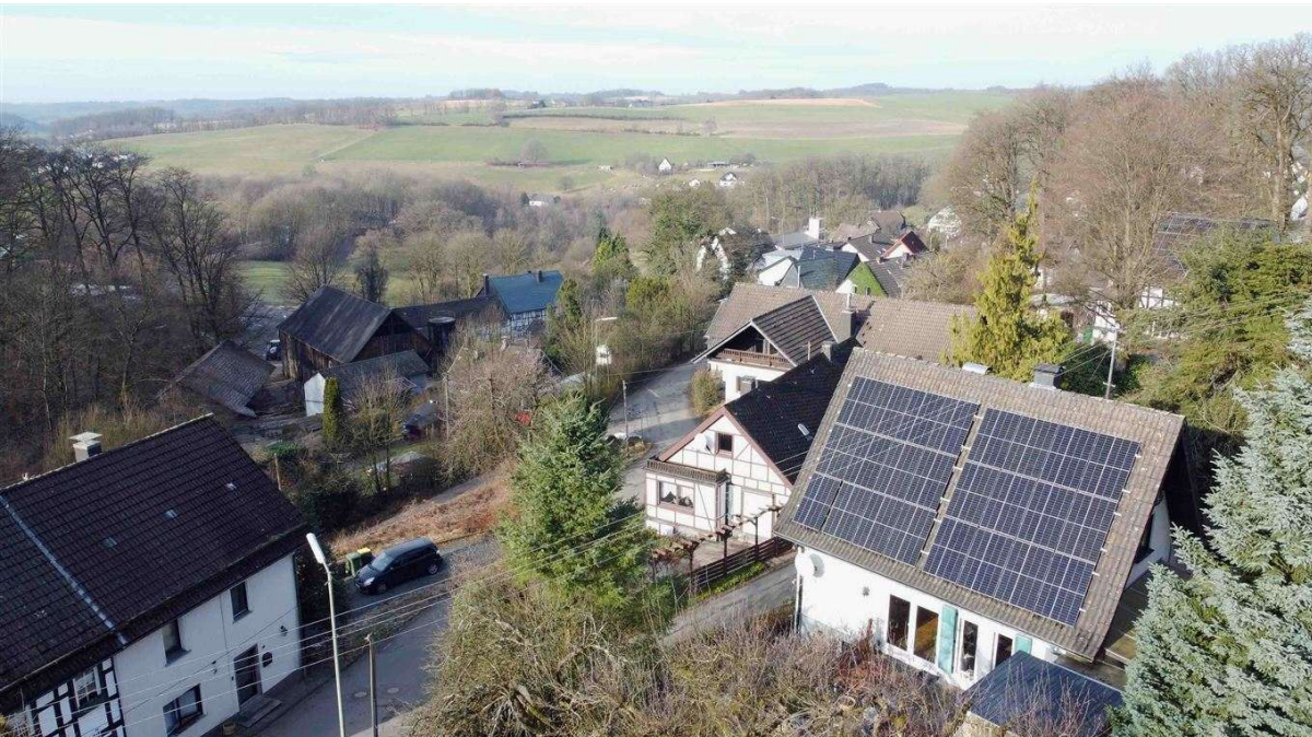
...mit Fernblick. Große PV-Anlage, Baujahr 2022
