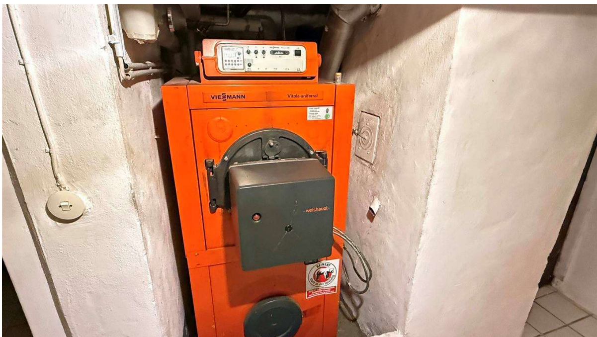
Ölheizung, Baujahr 1986, Brenner Baujahr 1999
